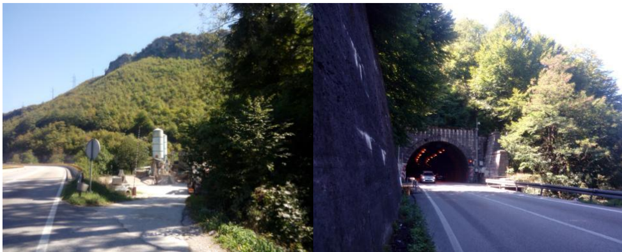
c) javno zemljište na istočnom ulazu u tunel
