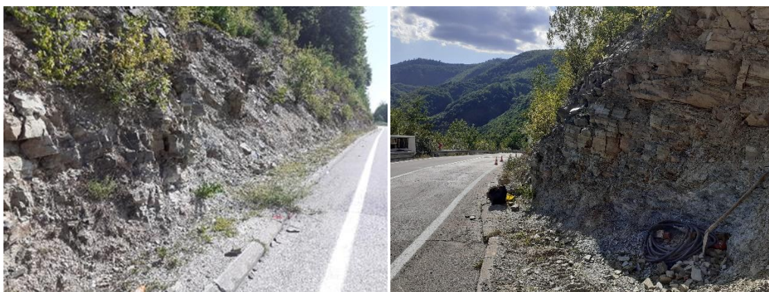
Prikaz degradirane stijenske mase podložne uticaju atmosferilija
