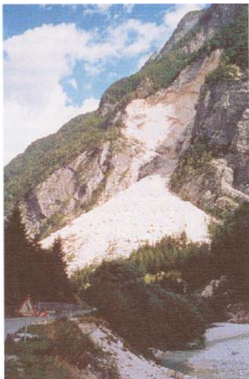
Slika 6.38: Stjenovito podoravanje velikih dimenzija - cestu je moguće zaštititi samo sa galerijom
