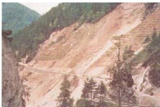
Slika 6.42: Sanacija padine-provalije sa popletima, živim četkama, zatravljivanjem i pošumljavanjem
