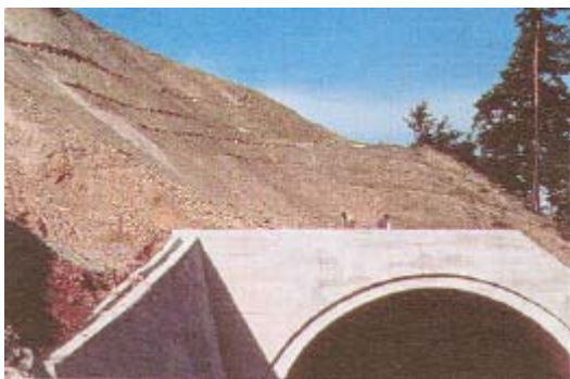
Slika 6.39: Uredjenje padina sa popletima, sjetvom na prostirku(stelju) i pošumljavanjem
