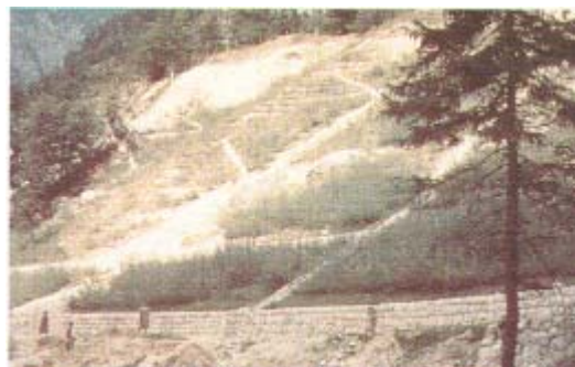
Slika 6.44: Uredjenje površinske i dubinske odvodnje te biotehničko utvrđivanje padine godine 1960
